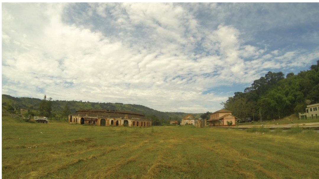
Figura 29 – Planície fluvial do Rio Grande no município de Ribeirão Vermelho. Ao fundo, uma rotunda ferroviária do início do século XX destruída pelas sucessivas inundações.
